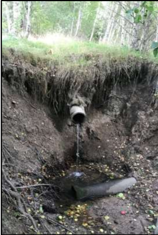
Figur 7. Det täckta betongröret som mynnar i det öppna diket. I botten på diket syns ett betongrör.
